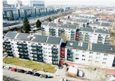
© LORENZ ENERGIE GmbH
