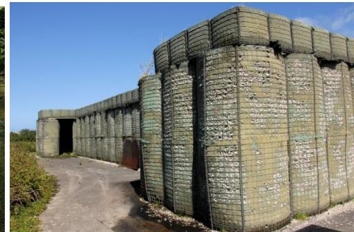
Рис. 3.14. Комбіновані споруди за першим рівнем захисту із рамних конструкцій, плит та габіонів: схема, металеві рами та приклади захисту елемента ОКІ
