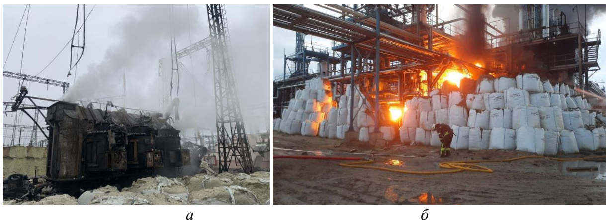
Рис. 6.6. Неспрацювання систем інженерного захисту першого рівня: знищення трансформатора після прямого влучання ракети рф, який забезпечував світло для 400 тисяч споживачів, захист із бігбегів зруйновано (а), знищення нафтопереробного вузла унаслідок прямого влучання “Шахіда-136” (б)
