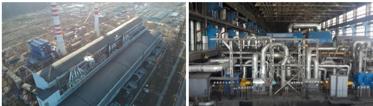
Рис.1.16. Зовнішній вигляд і турбінна зала об'єкта-представника ТЕС
