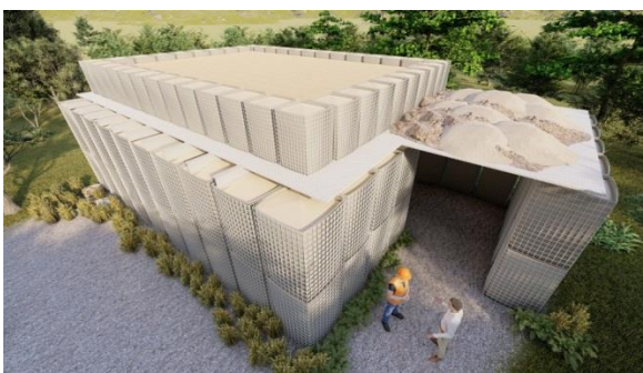
Рис. 3.14. Комбіновані споруди за першим рівнем захисту із рамних конструкцій, плит та габіонів: схема, металеві рами та приклади захисту елемента ОКІ
