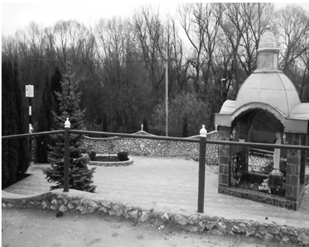
Будівництво площадки біля джерела
