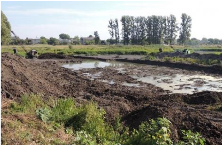
Роботи із поглиблення та розширення акумулюючої водойми
