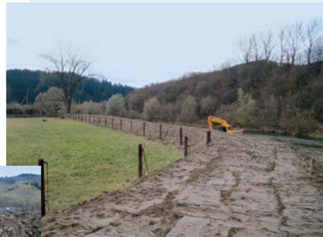
Після розчистки русла та виконання культуротехнічних робіт After the river course clean-up and land clearing activities
