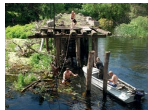
Прибираються перші прольоти аварійного моста
